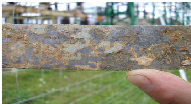
Makročlánková vzdálenost mezi místem důlkové koroze a chráněným pomíneralizovaným Zn je řádově v cm
